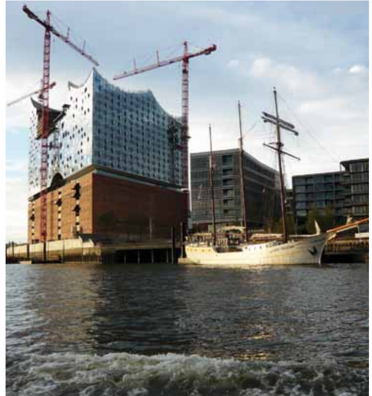
Die Elbphilharmonie im Bau ©Clemens Schwalbe
