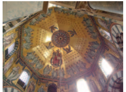
Deckengewölbe im Aachener Dom ©Simone Rüdiger
