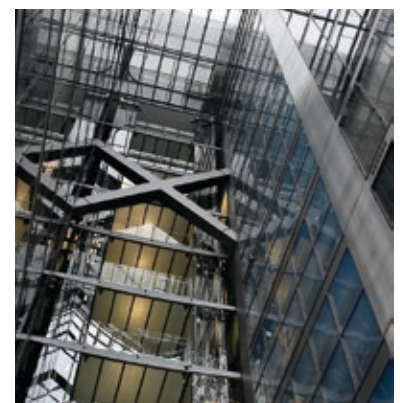
Stahlverbundstützen zwischen Turmhälften
