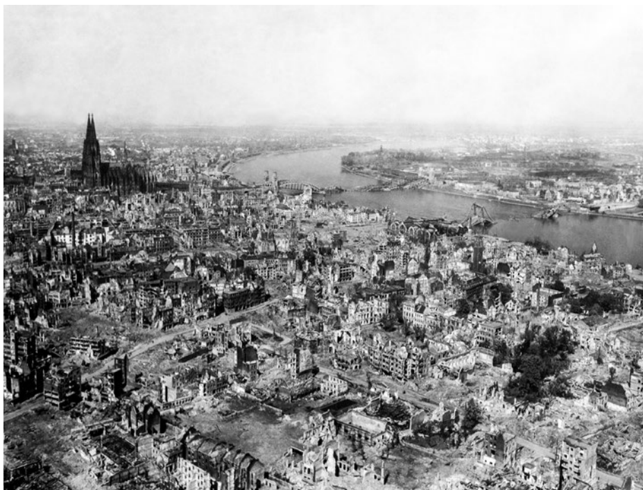
Köln 1945: Die Alliierten bombardierten die Stadt 262 Mal. Der Dom wurde durch die zahlreichen Angriffe beschädigt, doch nicht zerstört.
